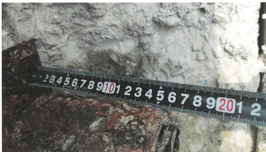
Obr. 3: Detail předsazení obnažené kotvy o cca 160 mm – zkušební plocha Z1.
