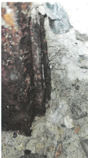
Obr. 5: Obnažená kotevní deska je složena ze 3 ks tenčích desek.
