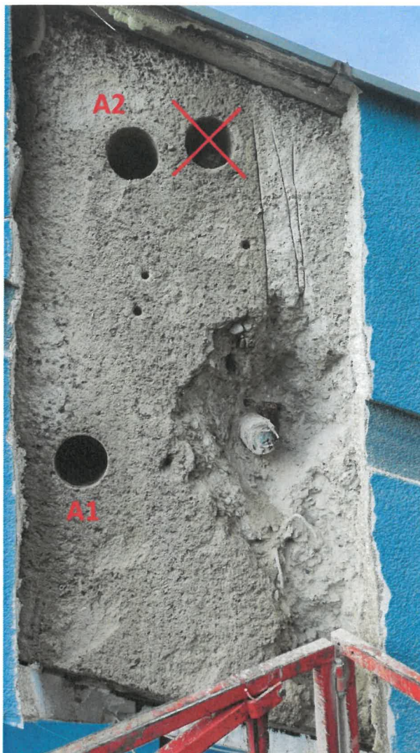
Obr. 1: Horní část zkušební plochy Z1 s obnaženou kotevní oblastí.
